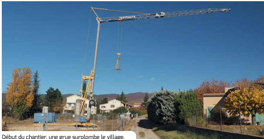
Début du chantier, une grue surplombe le village.
