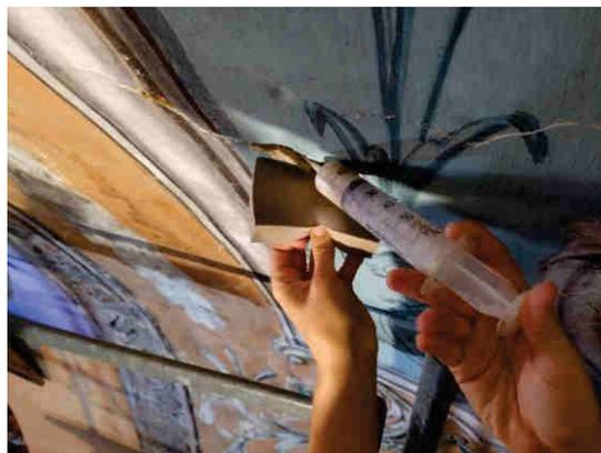
Traitement des décollements d'enduit par injection de chaux hydraulique (PLM)
