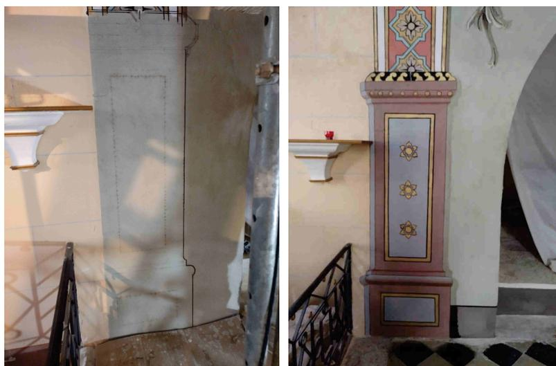
Restitution complète du pilastre nord en symétrie du pilastre sud, peinture au silicate
