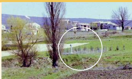
La station d'épuration dans les années 1980, depuis les arbres ont poussé.
