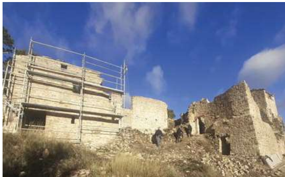
Place du Balaire, tous les bâtiments sont stabilisés.
