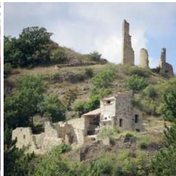
Les travaux continuent au Vieux-Montlaux.
