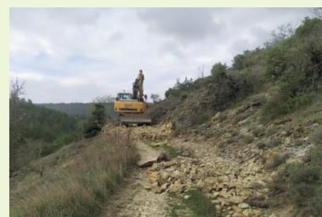
■ Réfection du chemin du Vieux-Montlaur, depuis le cabanon jusqu'à la ferme des Guérins, avec broyage des pierres et compactage, afin de permettre aux entreprises d'accéder sur le site.
